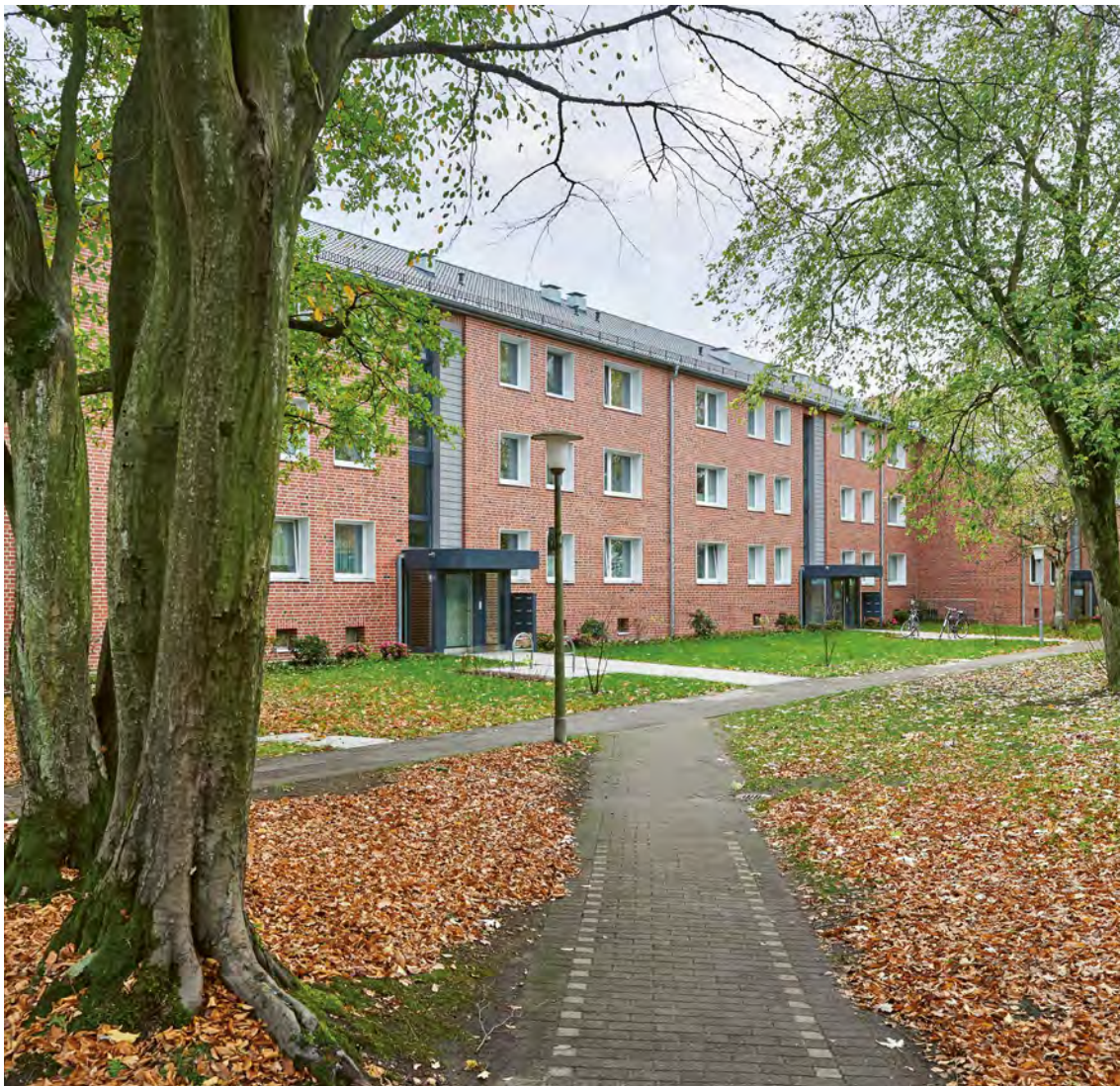
Diese Ansicht zeigt das Ergebnis des ersten Bauabschnitts unserer energetischen Modernisierung der Hans-Schwenkel-Wohnanlage.
