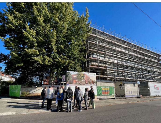
Station vor unserem künftigen Geschäftsgebäude am Rübenkamp.
